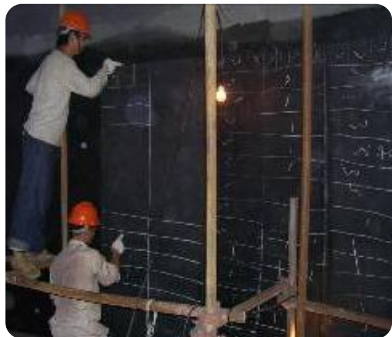
现场大型化工罐体衬胶
