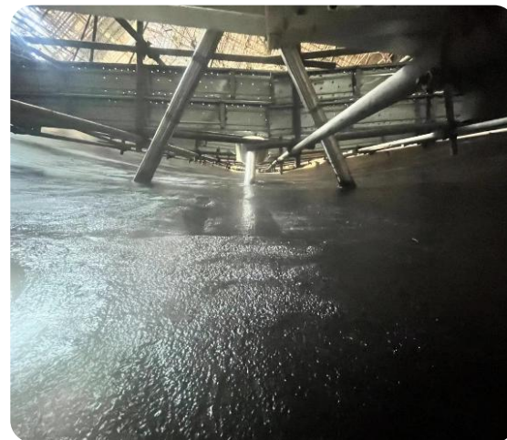
吸收塔橡胶衬里施工
