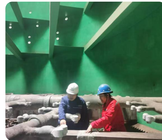
吸收塔鳞片衬里施工
