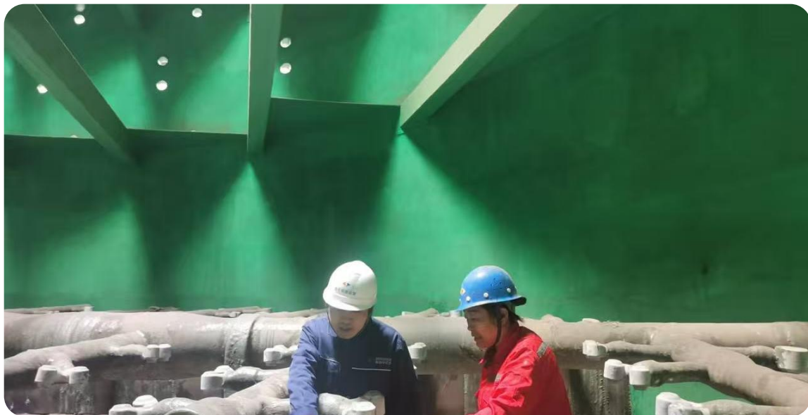
脱硫吸收塔鳞片防腐
