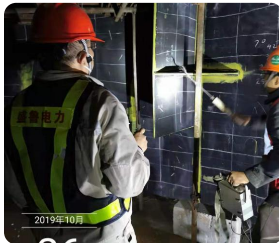
现场衬里施工
